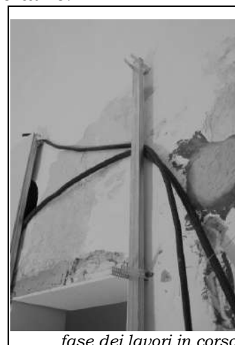
fase dei lavori in corso
