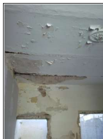
Situazione al momento dell'inizio dei lavori
